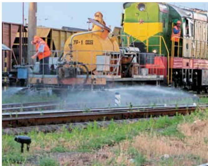
Идет обработка железнодорожного пути
